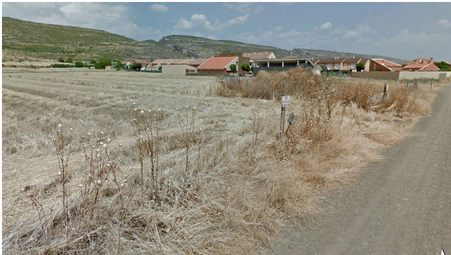
Figura 5. Vista exterior del Colegio Rural Agrupado (CRA) El Jarama desde calle Ingenieros Rafo y Rivera (Camino rural). Fuente: Google Earth
