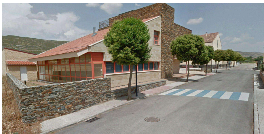
Figura 3. Vista exterior del Colegio Rural Agrupado (CRA) El Jarama desde calle Ingenieros Rafo y Rivera. Fuente: Google Earth
